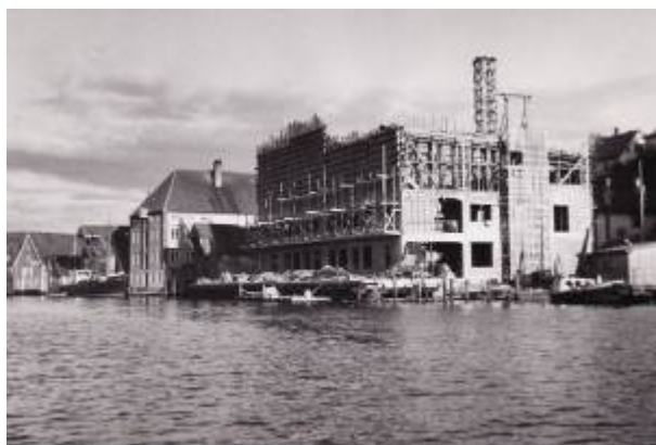
Fryseriet, også kalt «Fryså», under bygging. Foto: Ukjent/DF
