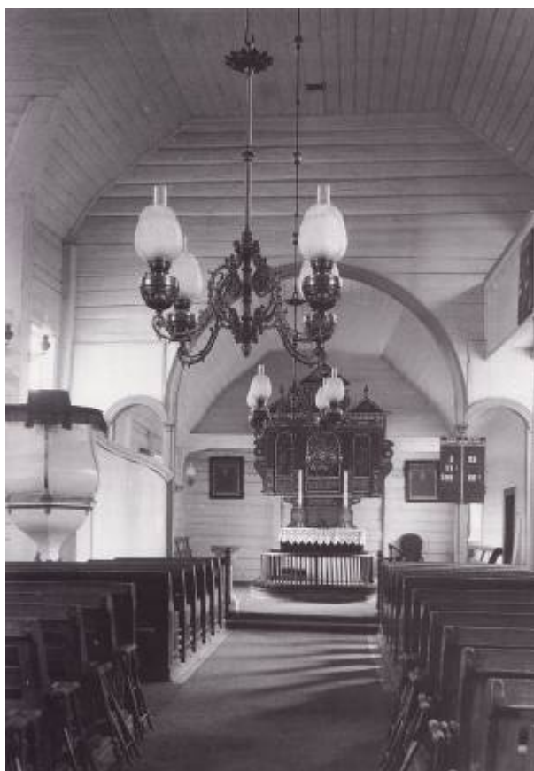
Interiør fra kirken før den siste innvendige restaurering. Foto: Riksantikvaren
