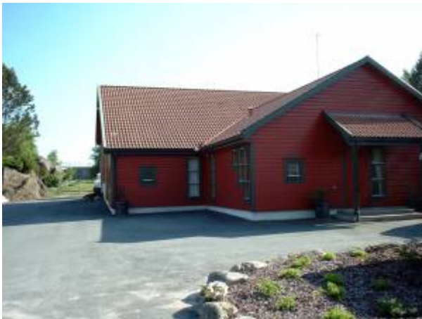
Vannbehandlingsanlegget ved Kråkevatn. Foto: Per Einar Lædre
