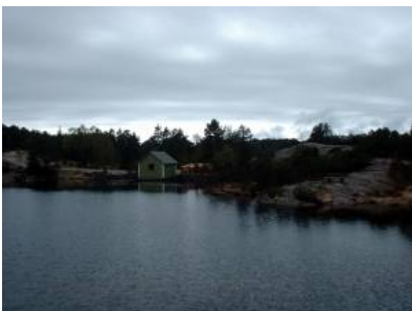
Inntakshuset i Kjerketjødne. Foto: Per Einar Lædre
