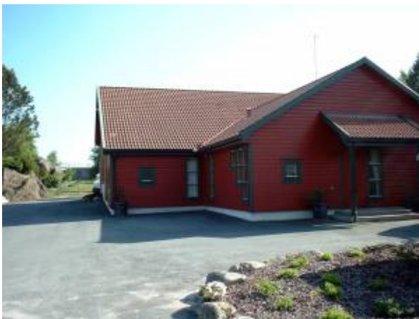
Vannbehandlingsanlegget ved Kråkevatn. Foto: Per Einar Lædre
