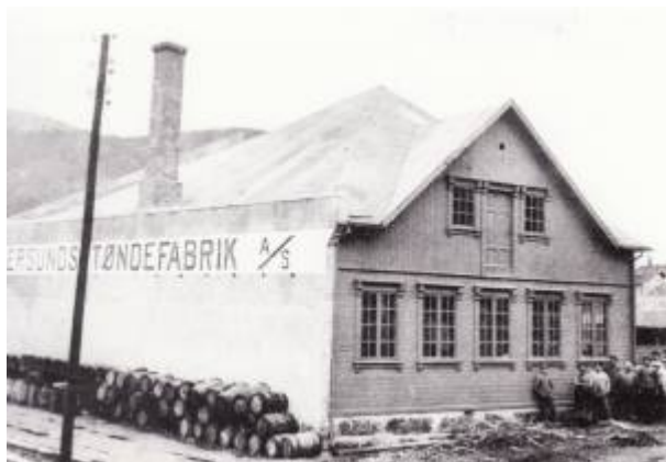
Tønnefabrikken i Møllegaten 9, 1917. Foto: Ukjent/DF
