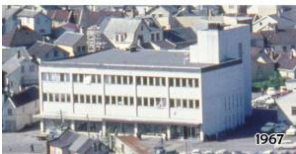
Bygging av Sentrumsgården trinn for trinn. Foto: Casper Feyling (farge) og Fotohuset (svart-hvitt), 1962-1967.
