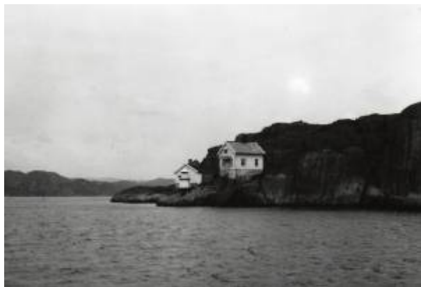
Grunnesundholmen fyrstasjon, 1963. Foto: Fotohuset/DF
