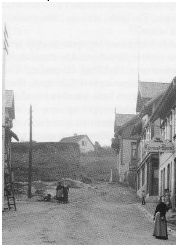
Jernhaugen under utgraving til venstre i bildet. Foto: P. A. Flak/DF
