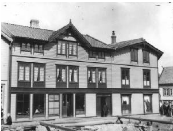
Posts sal lå i andre etasje i Storgaten 12. Foto: E. H. Torjusen/DF
