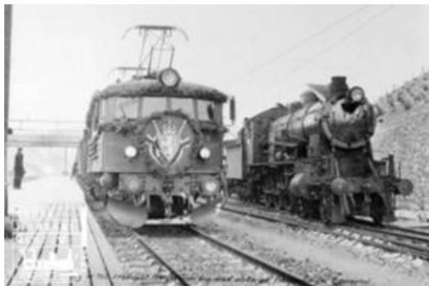
Egersund stasjon med åpningstog for elektrisk drift på Sørlandsbanen i 1950, tog 702 trukket av elektrisk lokomotiv type EI 8 nr. 2065 ved siden av damplokomotiv type 30b. Foto: Ukjent/Norsk Jernbanemuseum; Jernbaneverket
