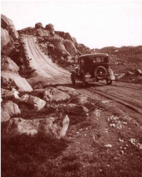
Fra Hegrestadjellet. Veien over Hegrestadjellet ble nedlagt som riksveg i 1940. Foto: Statens vegvesen
